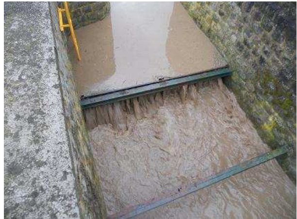
Entrave de la grille du bassin d'orage de l'Achonfosse par des tontes de gazon
