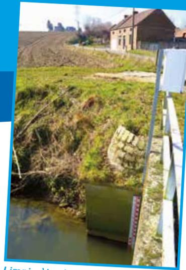
Limnimètre installé au Chemin Vert sur le Ry de Froye et au Stade Edmond Leburton sur le Coeurcq
