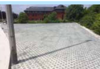
Parking à la rue de Scandiano : Enfin ! l'aménagement du parking rue de Scandiano en dalles alvéolées, procédé respectant l'infiltration des eaux de pluie dans le sol.
