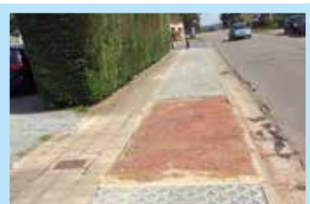
Rue de Virginal : Après le test concluant réalisé en 2015, nous poursuivons la pose de dalles alvéolées sur la zone de stationnement, procédé respectant l'infiltration des eaux de pluie dans le sol.
