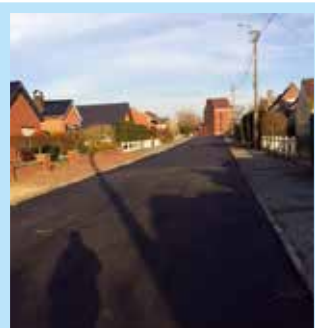
Rue Henri Wautier Réfection de la voirie terminée.
