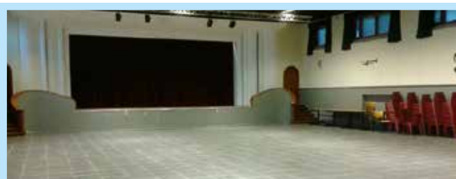
Académie de Musique Rénovation de la salle de spectacle de l'Académie par la pose d'un nouveau carrelage par notre Service Bâtiment.
