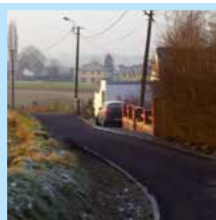
Rue du Radoux Enfin terminée.
